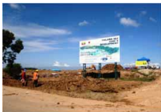
造成が進むティラワ SEZ(14年11月撮影)
